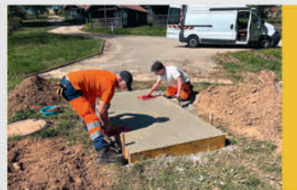
Réalisation de 2 dalles bétons pour accueillir des bancs Gîtes du Vieux Poirier
